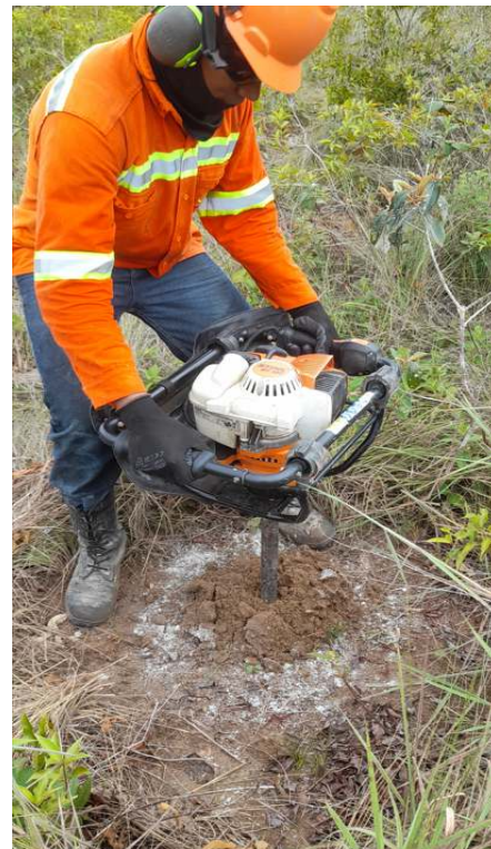
Hoyado e incorporación de cal.
